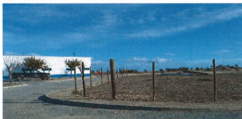
Colocação de vedação no terreno em São Marcos do Campo
